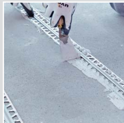
7 Profily do dilatačních spár upevněte např. stěrkou SCHÖNOX® ZZ.
